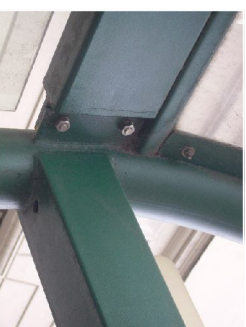
Particolare innesto copertura
